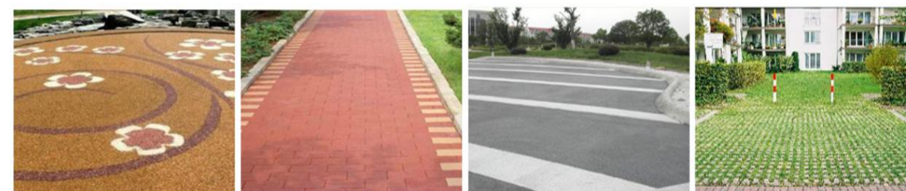
图10-11 透水铺装实景图
