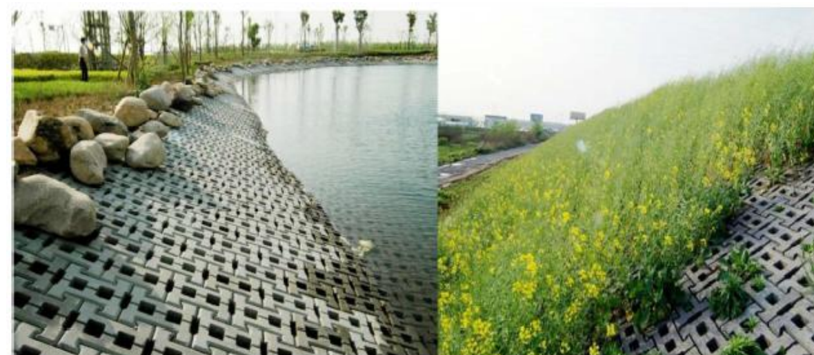
图10-7 连锁式护坡砖在生态护坡上的应用
