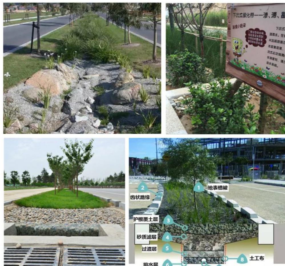
图10-12 下沉式绿地、生物滞留带实景图
