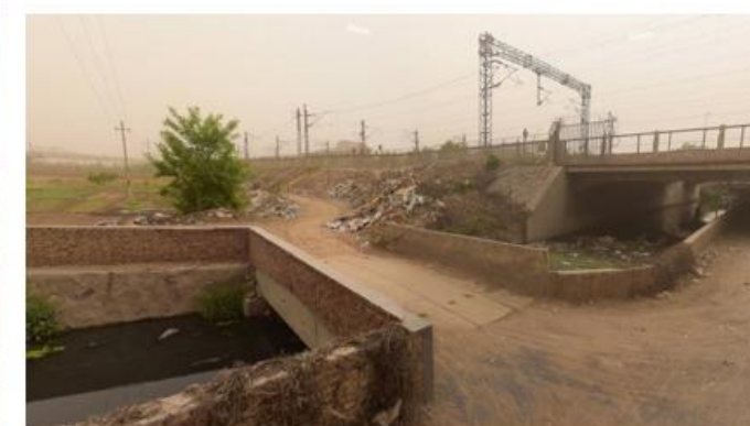
图6-4 明渠段与暗涵交接处
