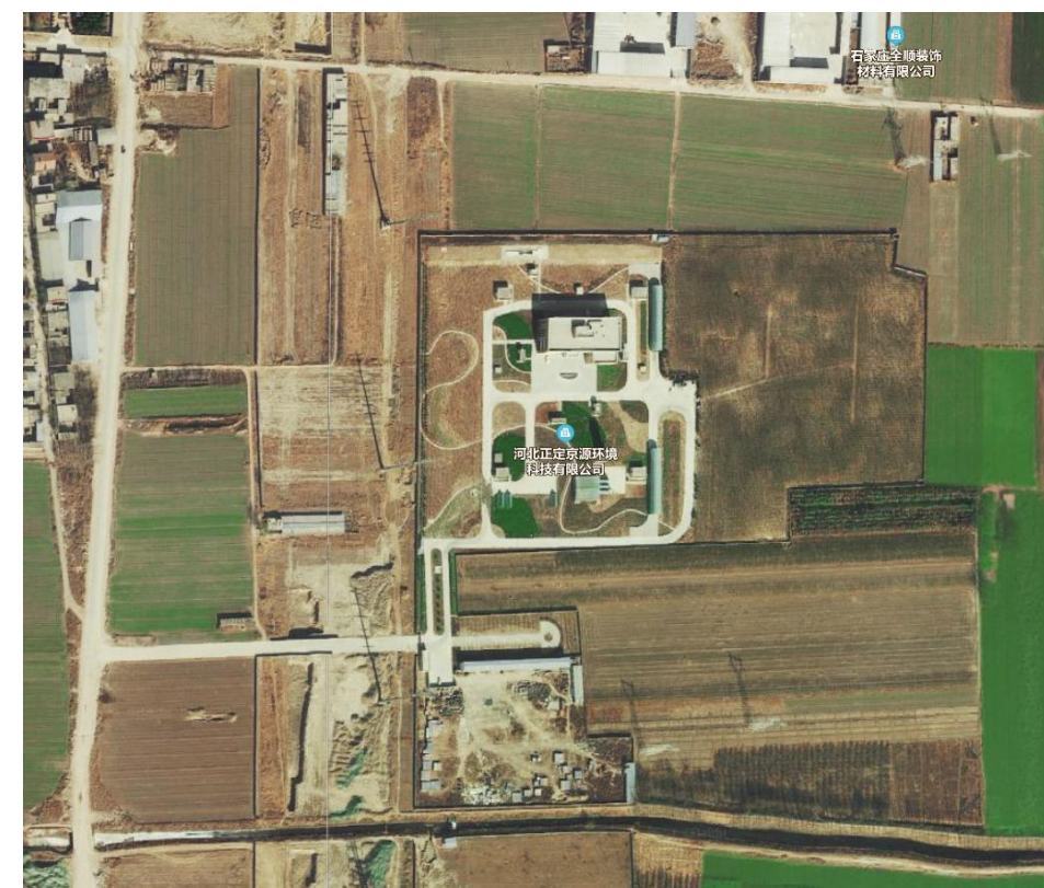
图7-3 现状正定新区污水处理厂（全地下式）
